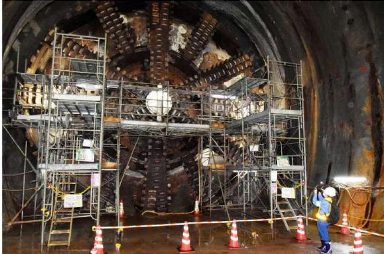
最初の岩塊の撤去を終えた羊蹄トンネルの掘削現場
