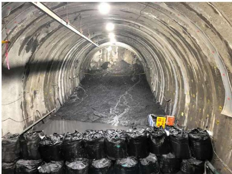
軟弱な土砂が流入した渡島トンネルの掘削現場（鉄道・運輸機構提供）
