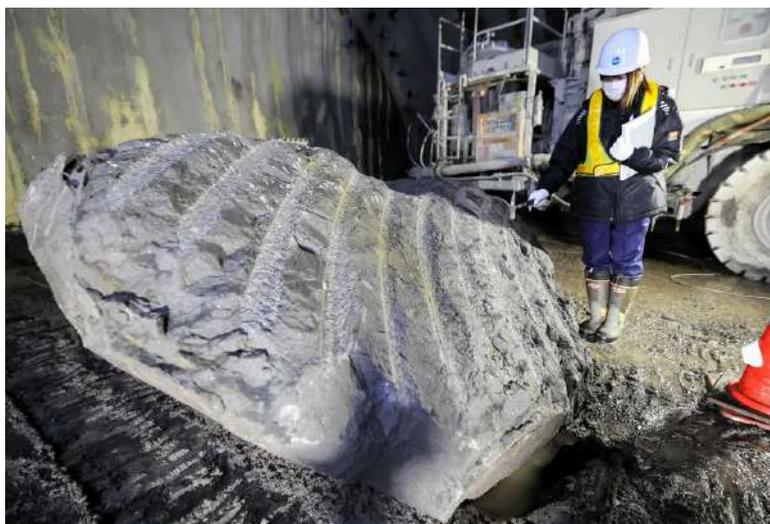
羊蹄トンネルで見つかった岩塊の一部。表面にシールドマシンが削った跡が残る
